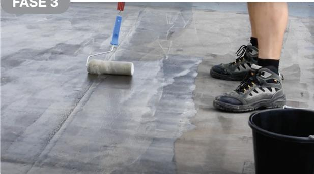
Aplicación de **imprimación específica** para la superficie de colocación existente.
