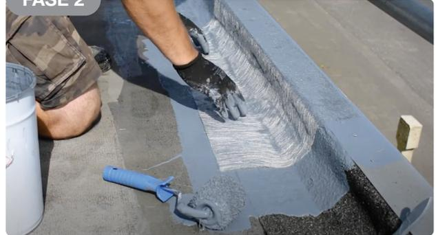
Armadura del perímetro y de los detalles constructivos con membrana líquida **STARFLEX** y tejido **STARTEX NW DETAILS**.
