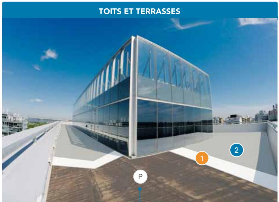
P Surface de pose en béton, membrane bitumineuse, PVC ou autre
