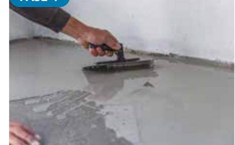
Aplicación de dos capas de membrana líquida **STARFLEX C** con tela tessuto de armadura **STARTEX FC** interpuesta.
