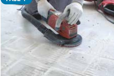
Preparación, limpieza de la superficie de colocación y arreglo de la existente.
