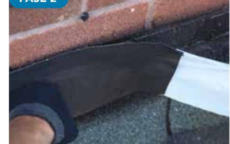
Armadura del perímetro y de los detalles constructivos con la membrana líquida **STARFLEX C** y el tejido **STARTEX FC**.
