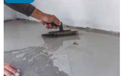
Application de deux couches de membrane liquide **STARFLEX C** avec tissu d'armure interposé **STARTEX FC**.
