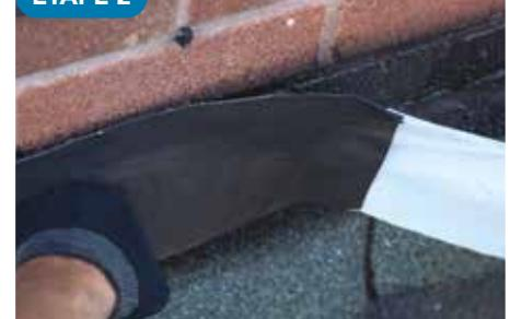
Armature du périmètre et des détails de construction avec membrane liquide **STARFLEX C** et tissu **STARTEX FC**.
