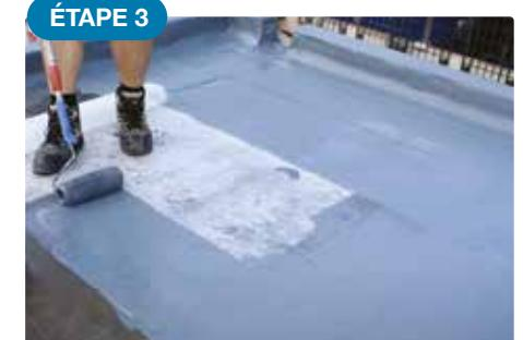
Application de **STARFLEX HYBRID** directement sur les cls ou la gaine même en présence d'humidité, de flaques d'eau ou de pluie.
