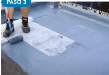
Aplicación de segunda mano de membrana líquida **STARFLEX HYBRID** con un consumo total de al menos 2,5 kg/m<sup>2</sup>
